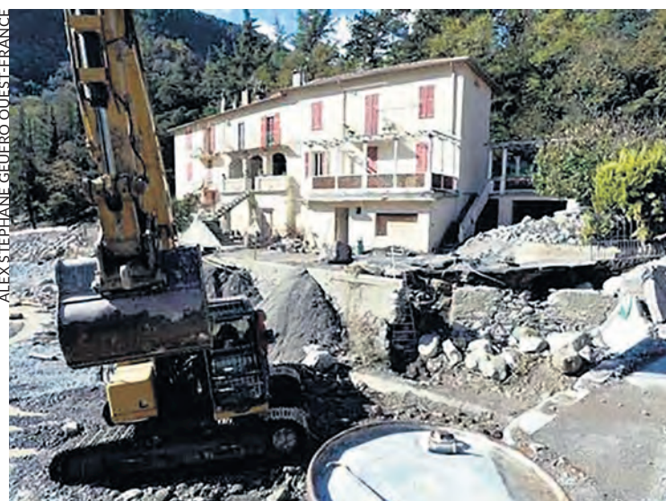
Breil-sur-Roya après la tempête.
