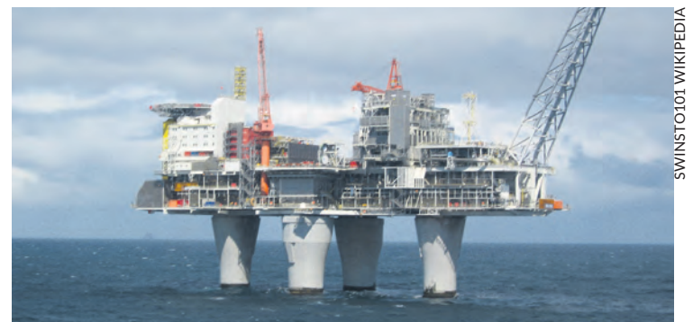
La plateforme d'extraction de gaz Troll A en mer du Nord.
