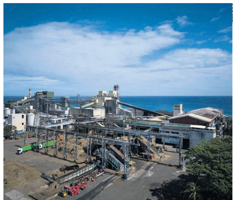
Usine de Bois Rouge.
