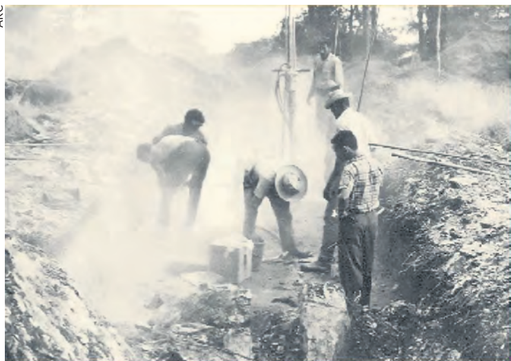
Au début des travaux de la base.
